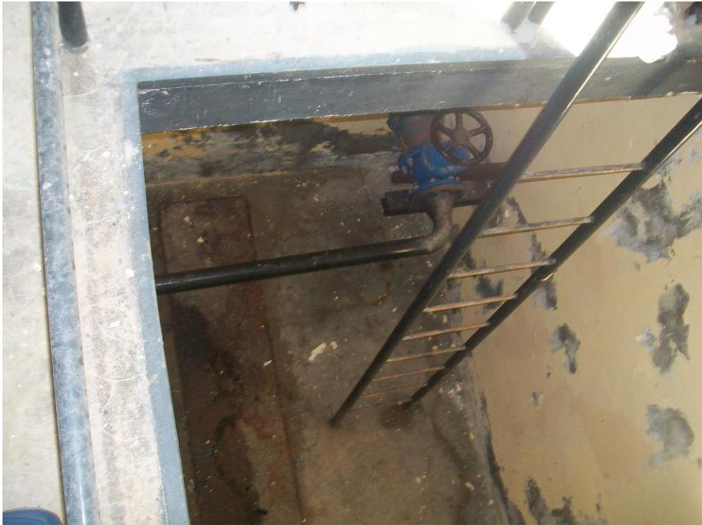
**Foto 54:** Camera di manovra: Condotta DN 150 dalla rete di Lettere (G.O.R.I. - condizione di emergenza)
