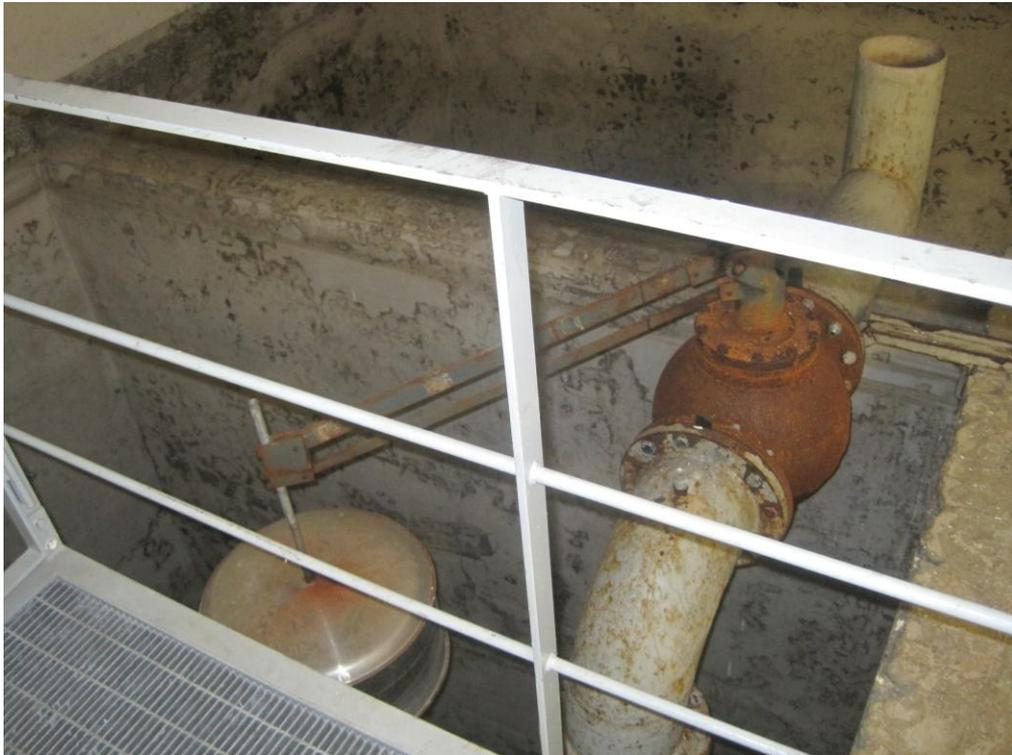
**Foto 19:** Vasca – Valvola di sezionamento con chiusura a galleggiante
