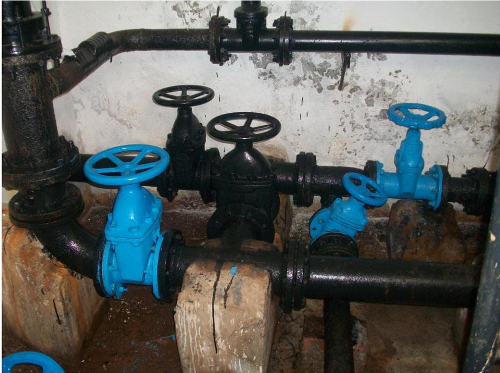
**Foto 43:** Particolare camera di manovra: tubazioni di arrivo e di presa con apparecchiature di sezionamento
