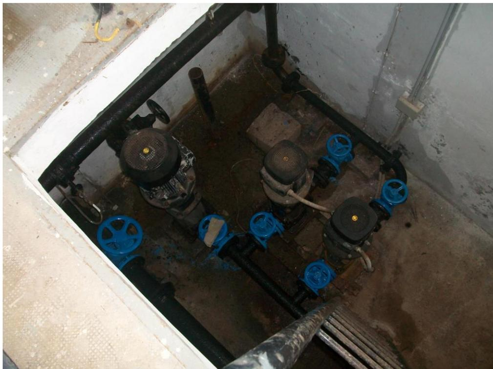
**Foto 41:** Serbatoio Casola Basso – Camera di manovra: elettropompe di sollevamento per Casola Alto
