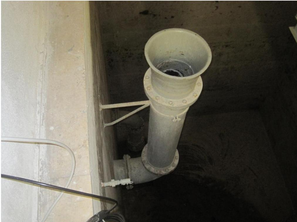
**Foto 17:** Vasca – Scarico di superficie con calice
