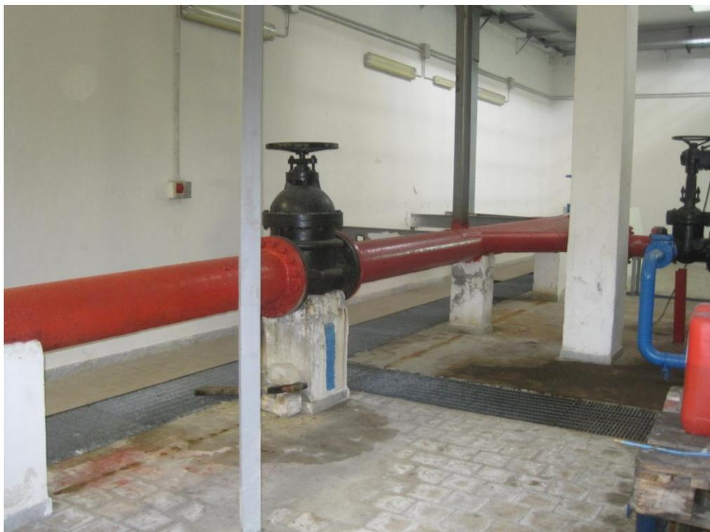
**Foto 25:** Locale pompe – Condotta di mandata generale e organo di sezionamento
