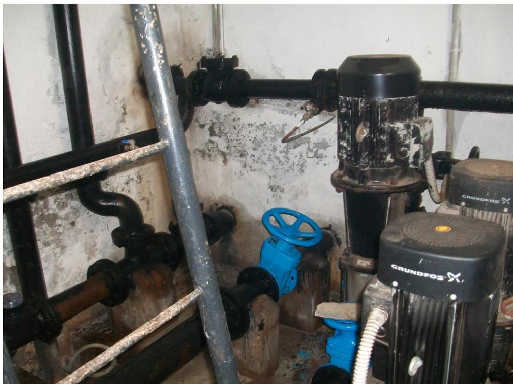
**Foto 42:** Particolare camera di manovra: elettropompe di sollevamento per Casola Alto, condotta di mandata generale ed apparecchiature di sezionamento
