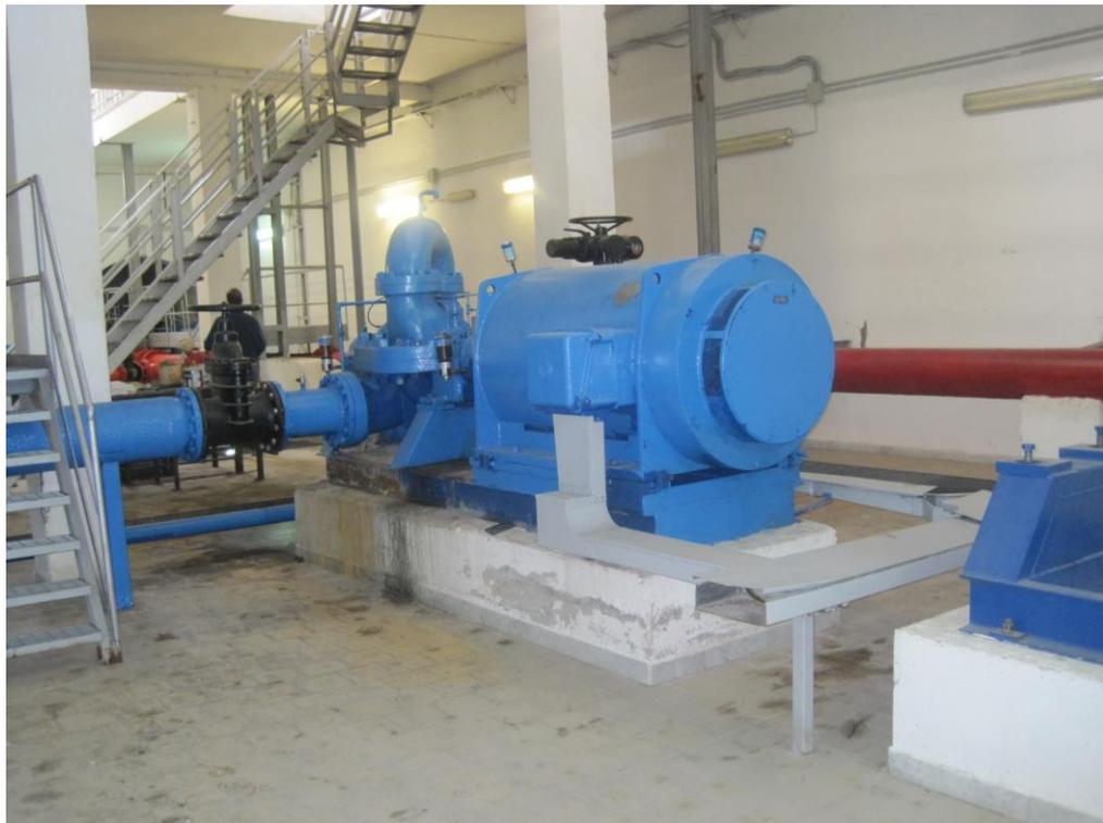
**Foto 26:** Particolare pompe – Elettropompa di riserva completa di condotte di aspirazione e mandata
