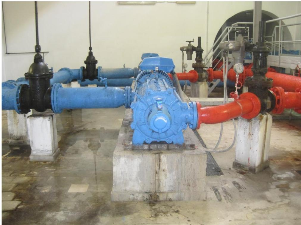
**Foto 24:** Particolare pompe – Elettropompa di servizio completa di condotte di aspirazione e mandata
