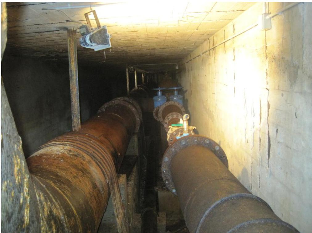
**Foto 11:** Cunicolo di servizio – Condotta DN 700/900 e DN 400 per S.Maria la Carità con sezionamento di linea e apparecchiatura di misura della portata
