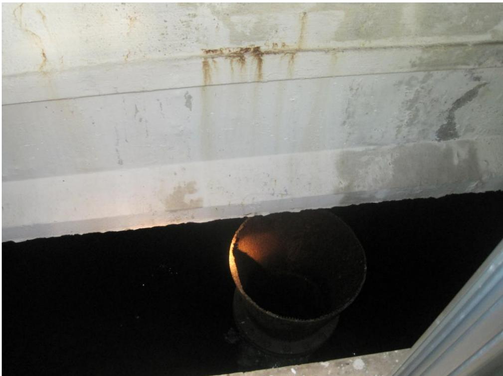
**Foto 13:** Vasche – Scarico di superficie con calice
