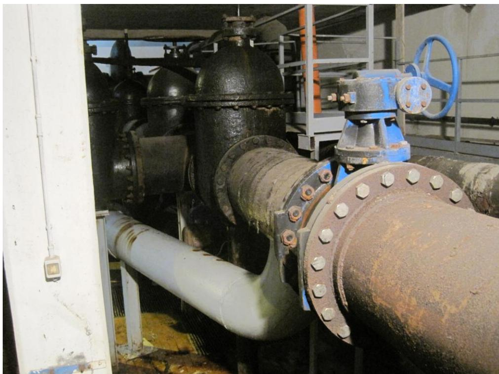
**Foto 5:** Camera di manovra – Condotta di aspirazione in derivazione dal DN 500 di presa
