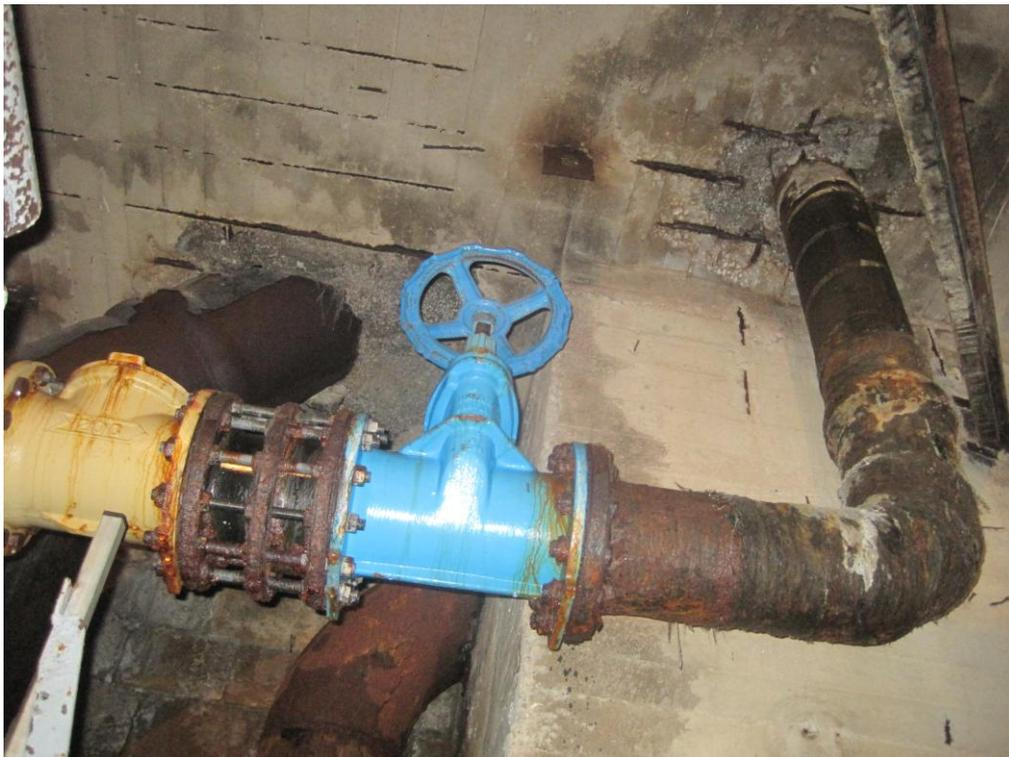
**Foto 12:** Cunicolo di servizio – Condotte in uscita dalle vasche e apparecchiatura di sezionamento
