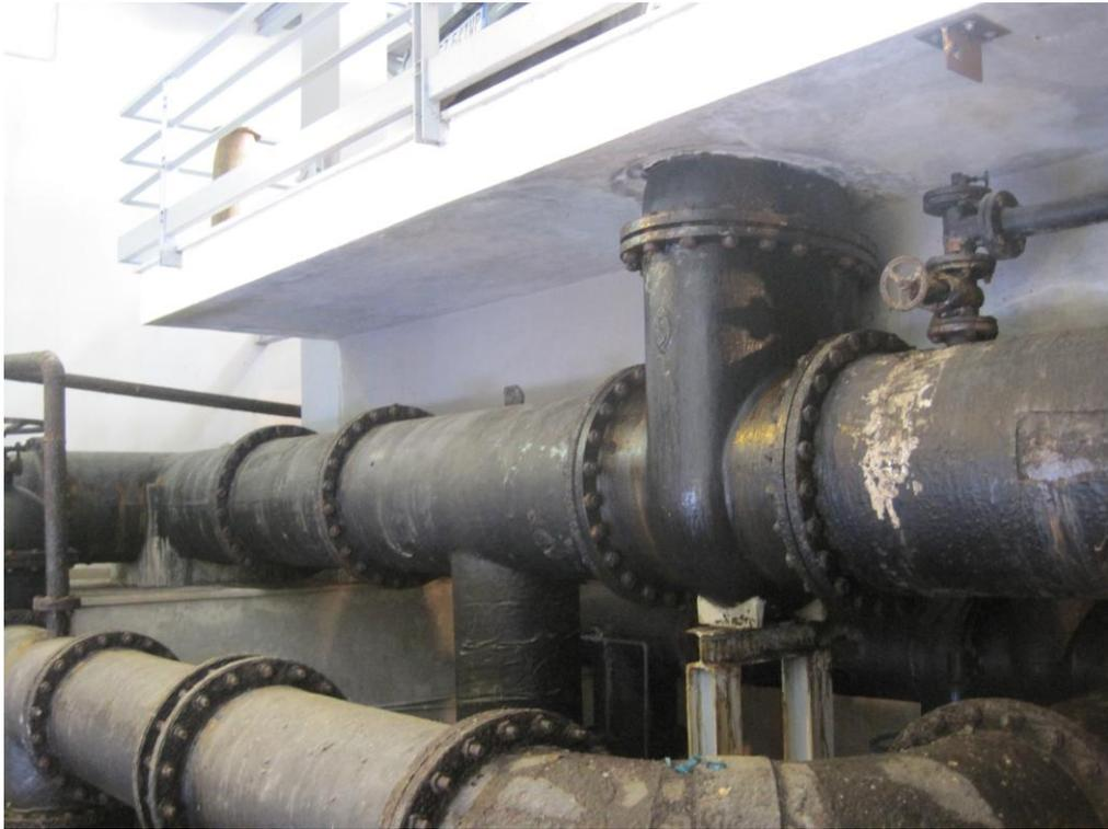
**Foto 8:** Camera di manovra – Condotta DN 700/900 in ingresso alle vasche e sezionamento di linea
