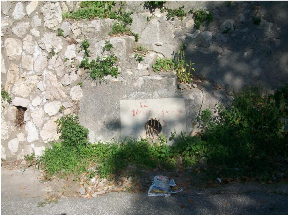
**Foto 48:** Serbatoio Casola Alto – Sbocco della condotta di scarico del serbatoio
