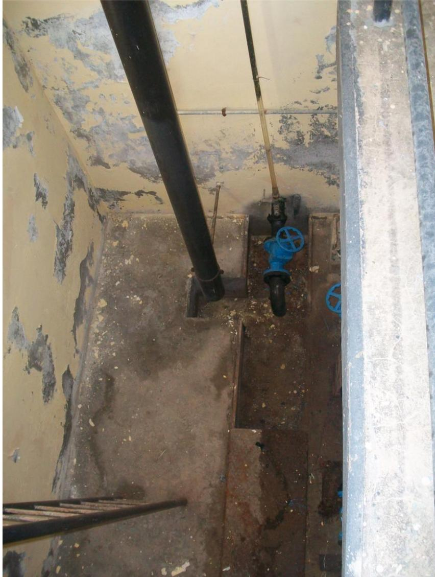
**Foto 53:** Camera di manovra: Scarico di fondo e di superficie
