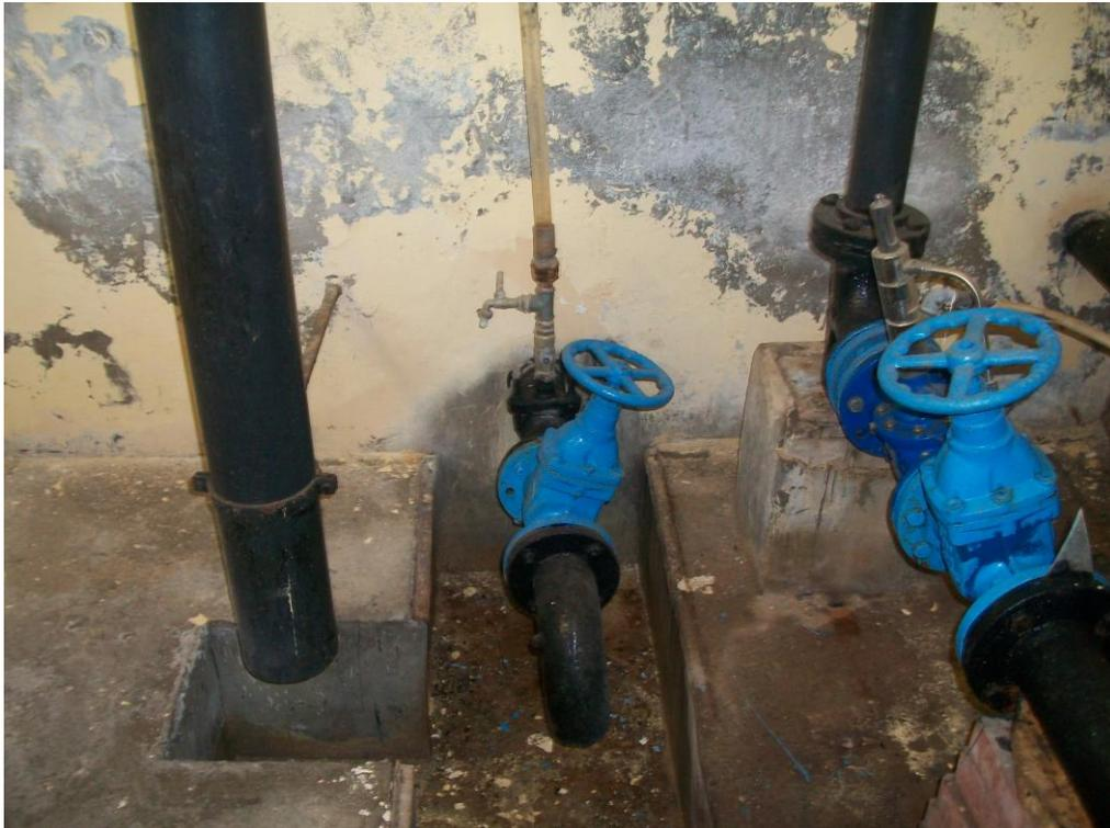
**Foto 56:** Camera di manovra – Condotte di scarico e alimentazione del serbatoio
