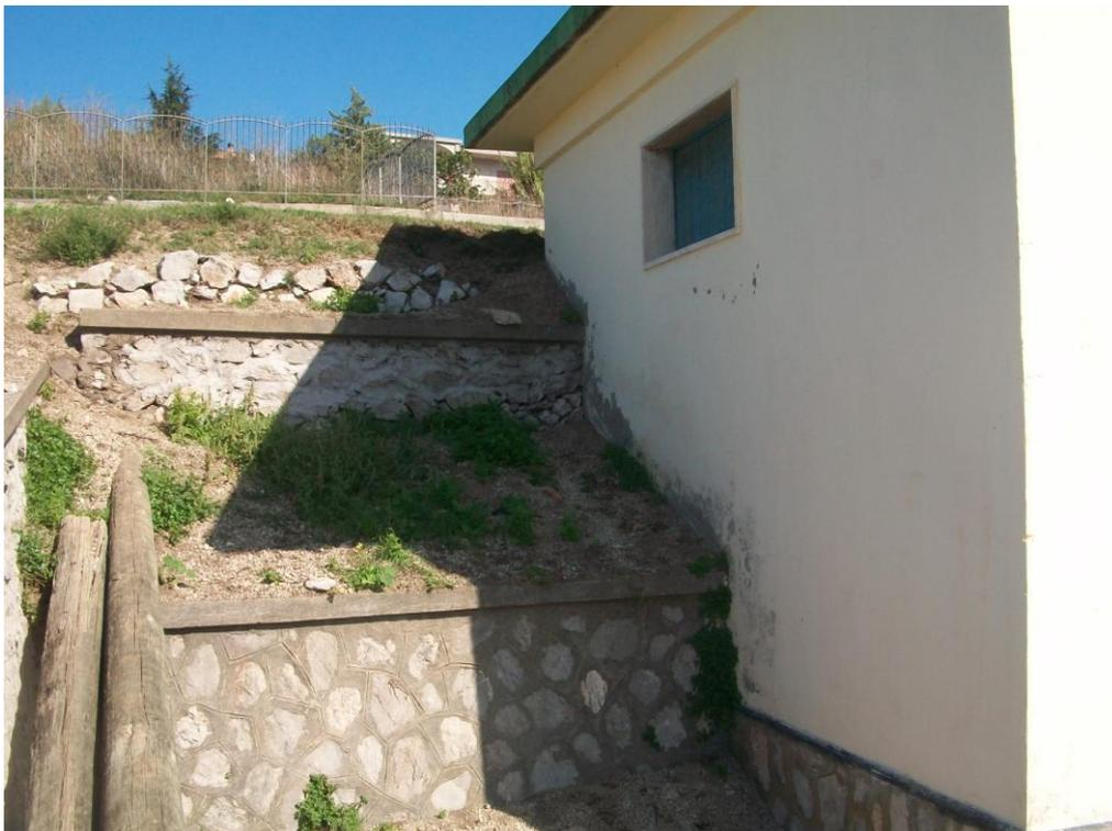
**Foto 49:** Serbatoio Casola Alto – Sistemazione area esterna: muri di sostegno
