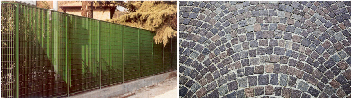
Figg.35-36 – Aspetto della recinzione metallica esterna e della pavimentazione in blocchetti di porfido
