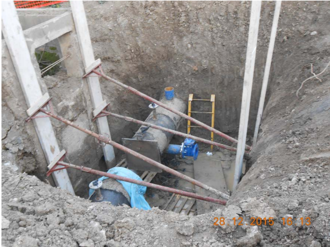
Figura 15: Sezionamento DN 550 prog. Km 2.00
