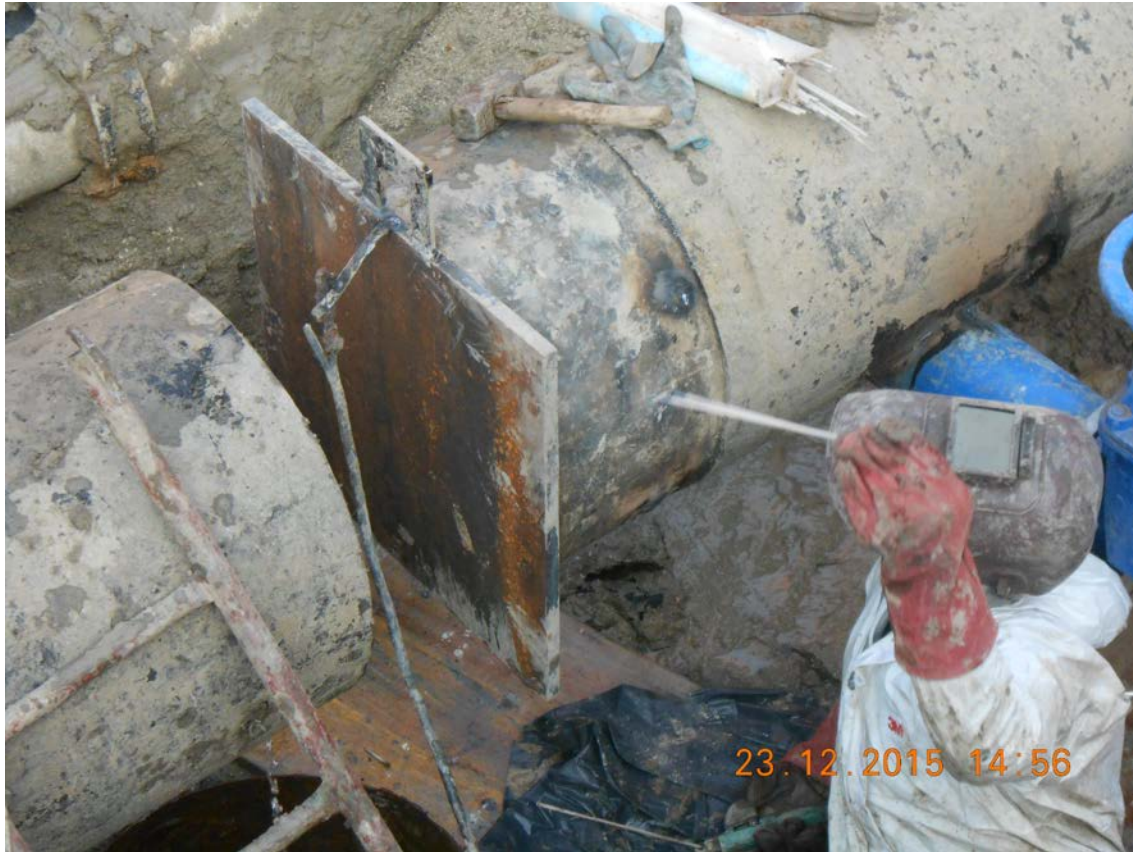
Figura 6: Prova di carico DN 550: particolare scavo prog. Km 1.0 profondità 1.10 m
