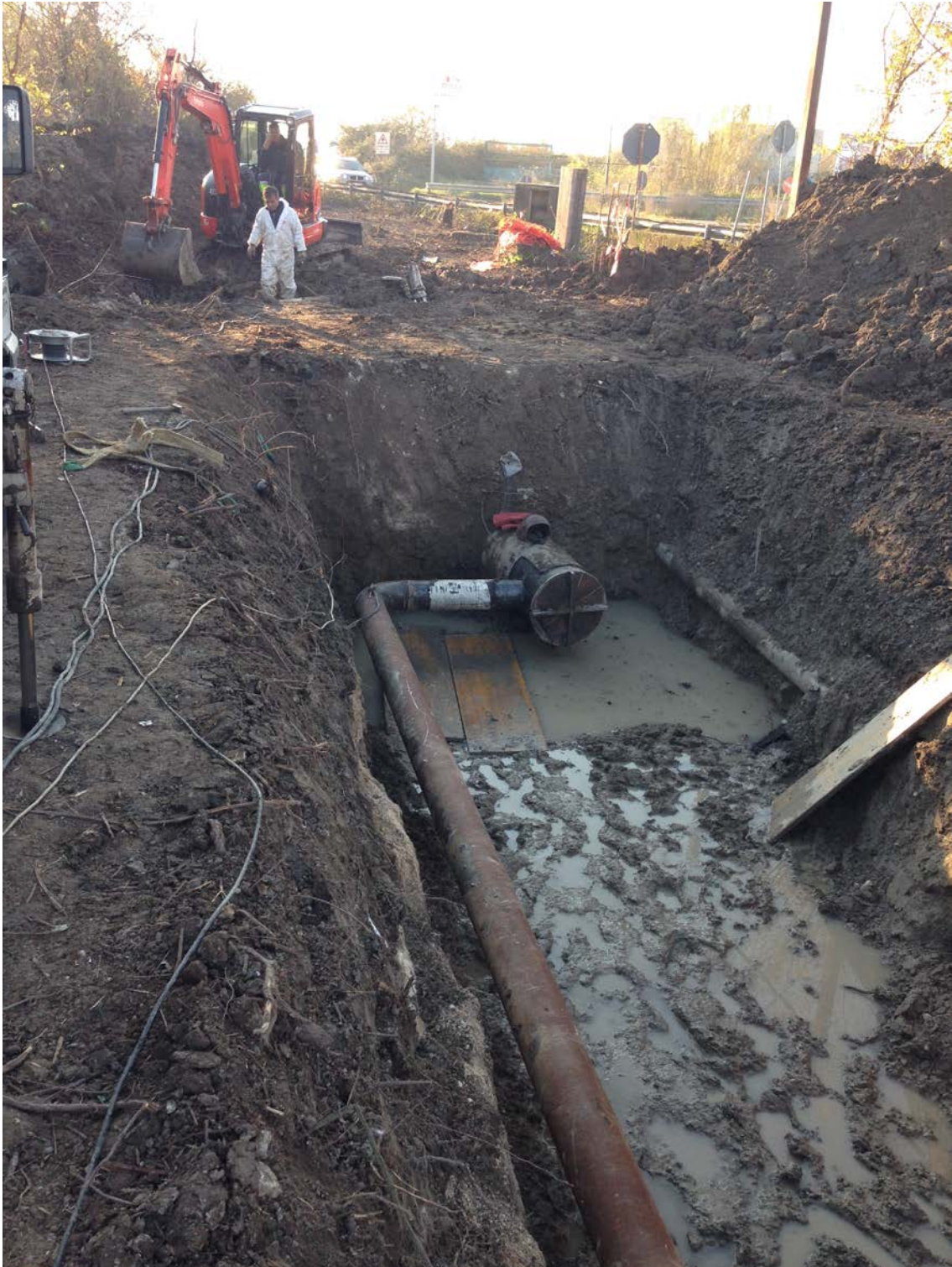
Figura 11: Esecuzione by – pass DN 200 Prog. Km 0.00
