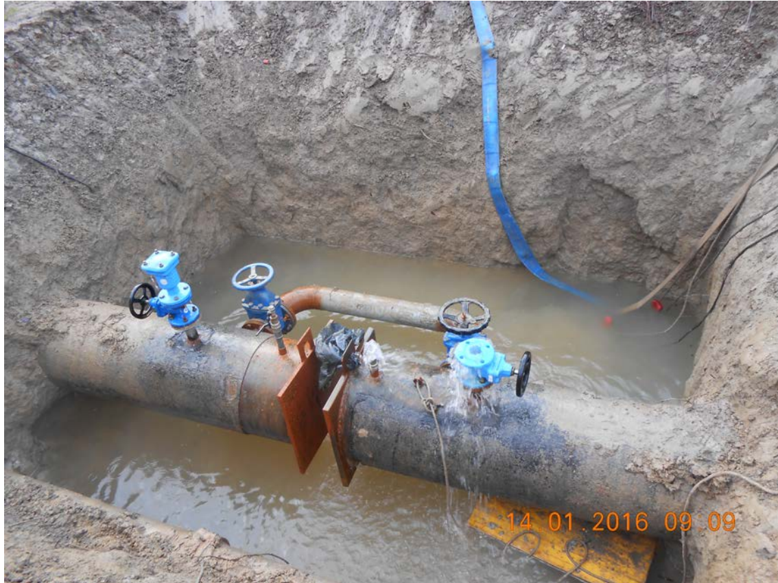
Figura 14: Sezionamento DN 550 prog. Km 1.00
