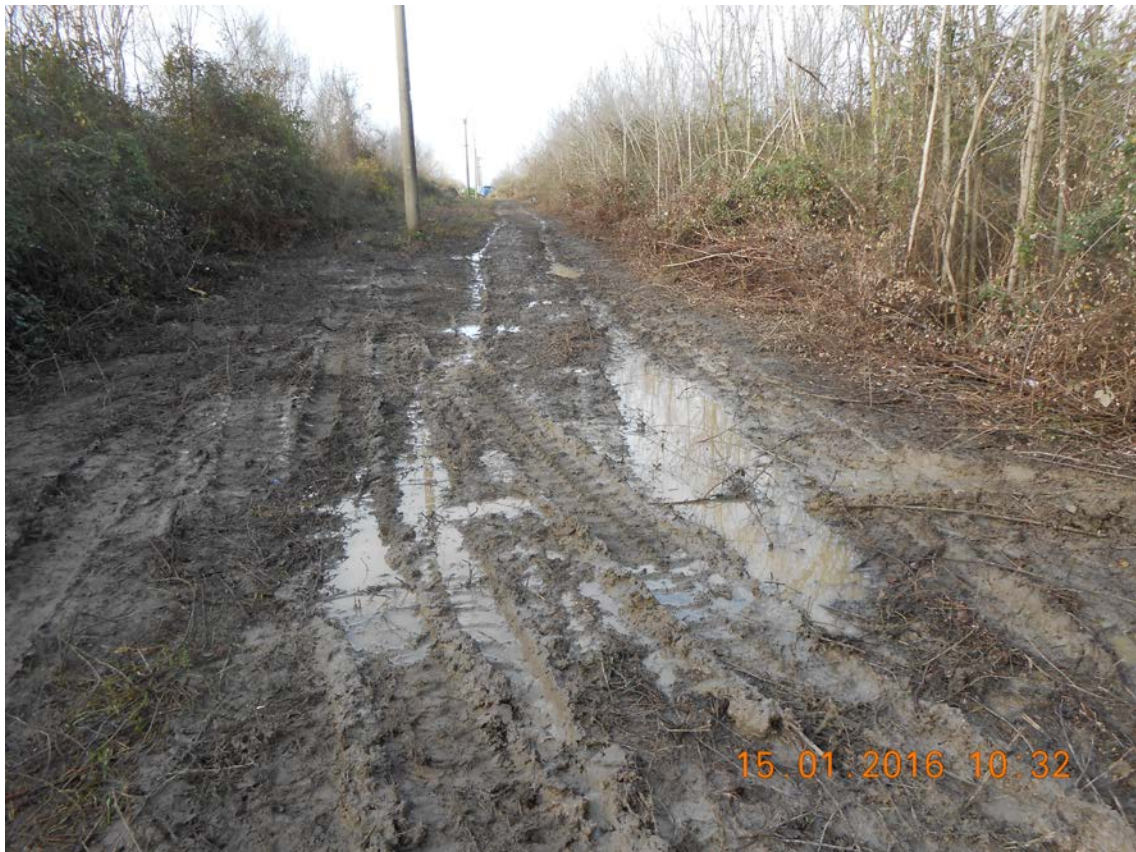
Figura 9: Pulizia area da prog.Km 0.00 a prog Km 1.20
