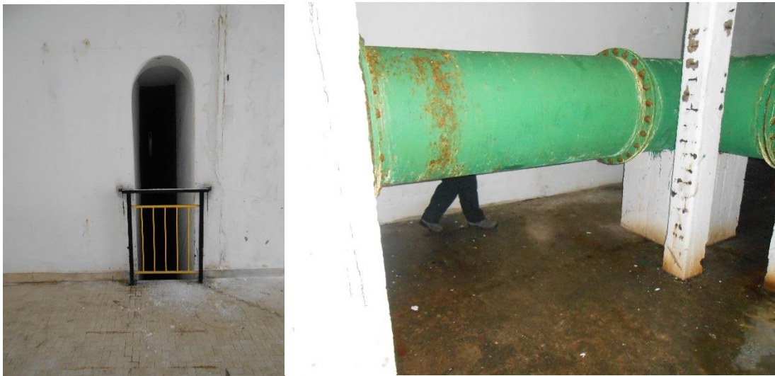
Primi cunicoli – tubazioni che ostruiscono l'accesso ai cunicoli adiacenti l'ingresso al serbatoio
