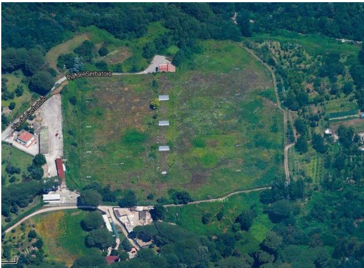
Vista generale delle aree esterne del cantiere
