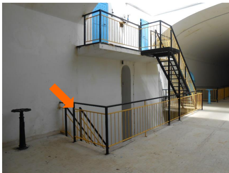
Atri cunicoli – accessi diretti ai cunicoli senza ostacoli mediante scale metalliche
