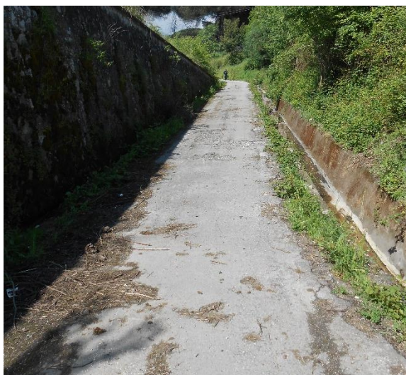
Vista strada di accesso al piazzale inferiore
