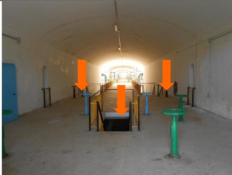
Corridoio centrale e scale di accesso al piano cunicoli
