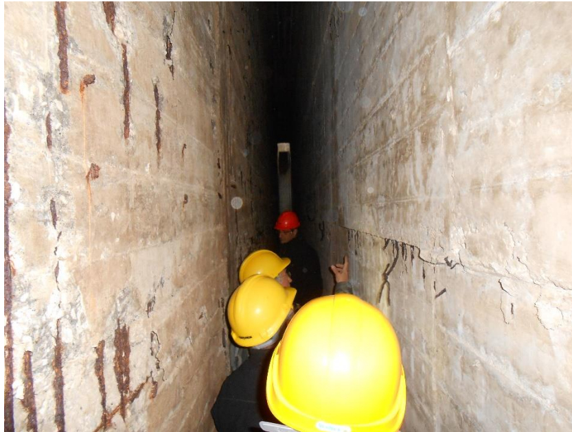
Vista interna di un cunicolo
