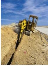
Trattasi della esecuzione di scavi a sezione obbligata eseguiti mediante l'utilizzo di mezzi meccanici.
