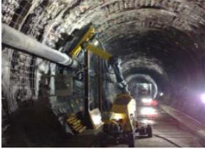
Trattasi dell'intervento di rimozione di strati ammalorati grossoloni mediante getto d'acqua ad alta pressione con tecnica robotizzata. In particolare verrà utilizzata una macchina guidata su binari, comandata da postazione remota prossima alla macchina stessa mediante radiocomando.
