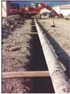
Trattasi della movimentazione e posa in opera di tubazioni in acciaio negli scavi predisposti e nella esecuzione delle saldature di assemblaggio dei vari elementi.
