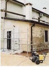
Trattasi dell'intervento di rimozione di strati ammalorati sottili mediante getto d'acqua ad alta pressione.
