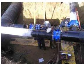
La rete verrà dotata delle necessarie apparecchiature per la intercettazione e la regolazione delle portate, saracinesche, apparati di riduzione di pressione ecc.
