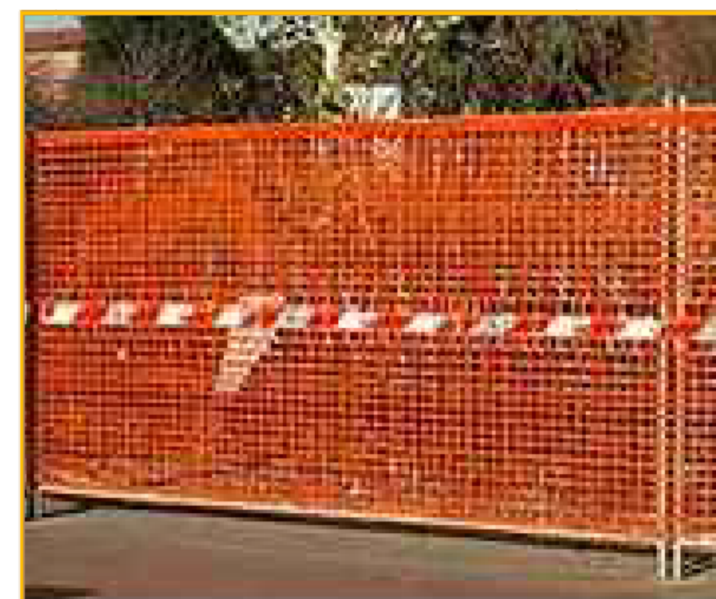
RECINZIONE TIPO TUBI INFISSI E RETE ELETTRORALDATA
