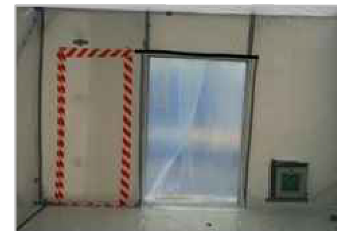
DELIMITAZIONE AMBIENTI CONFINATI (SERBATOI)
