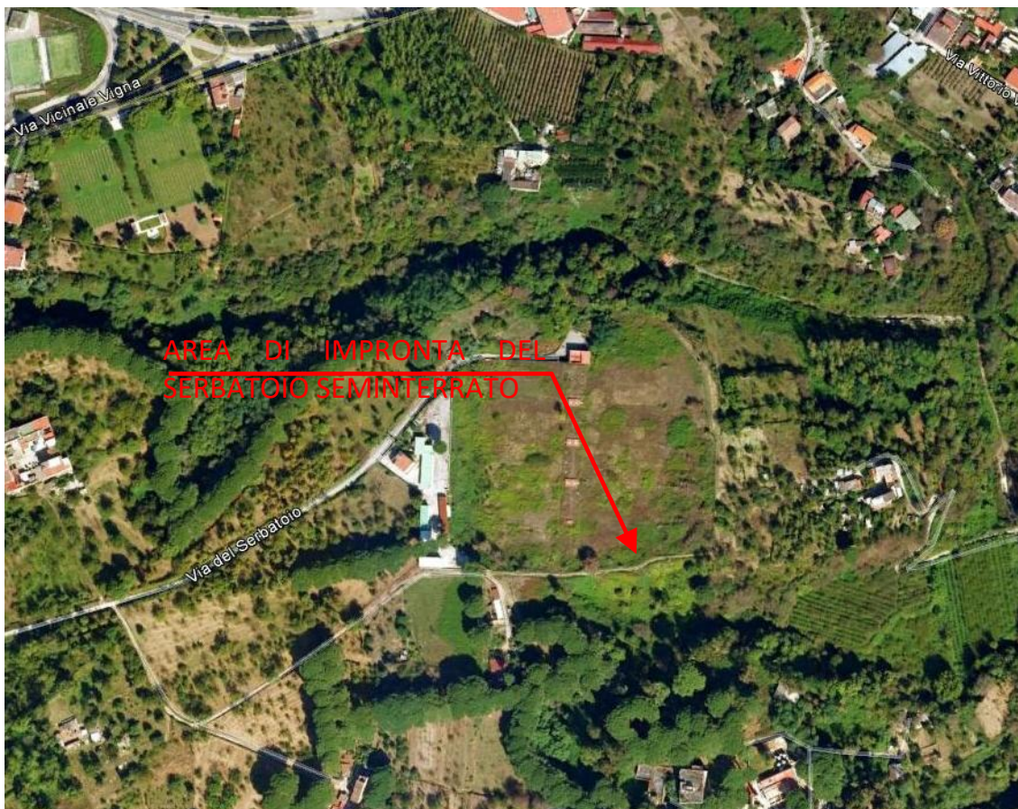
Fig.1. Vista dall'alto del serbatoio San Rocco
